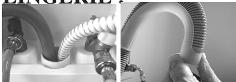
1. Si le tuyau flexible de CatGenie et celui de la machine à laver n'entrent pas facilement dans le déchargement, enlever les deux tuyaux flexibles. Mettre d'abord en premier le tuyau de CatGenie puis le tuyau de déchargement de la machine 2 Si le tuyau flexible de la machine a un guide, tenir ensemble le tuyau flexible de la machine et son guide et les mettre dans le déchargement.
