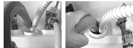
4. Un autre option est de mettre dans le déchargement les tuyaux flexibles avec le tube de déchargement de CatGenie en avant de la sortie du tube de déchargement de la machine à laver 5. Insérer les tuyaux flexibles jusqu'à les fixer solidement dans le tube de déchargement.
