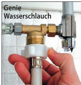
7) Schrauben Sie den Genie Wasserschlauch mit der Hand auf den T-Adapter. Benutzen Sie kein Werkzeug.
