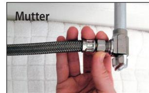
4) Drehen Sie den Kaltwasserschlauch vom Ventil ab. Verwenden Sie entsprechendes Werkzeug.
