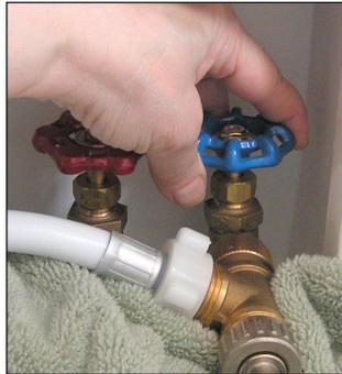
1) Legen Sie ein Handtuch unter den Anschluss. Öffnen Sie die Kaltwasserzufuhr. Kontrollieren Sie alle Leitungen auf Dichtheit. Benutzen Sie, falls notwendig, geeignetes Werkzeug, um die Anschlüsse nachzuziehen. **HINWEIS:** Benutzen Sie kein Werkzeug, um den weißen Plastikanschluss Ihres CatGenie nachzuziehen. Es hat eine Druckdichtung, die nur das Nachziehen mit der Hand erfordert.
