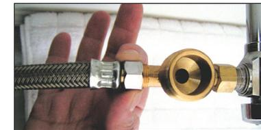
6) Schrauben Sie den Kaltwasserschlauch Ihrer Toilette auf den T-Adapter. Ziehen Sie ihn mit geeignetem Werkzeug fest.
